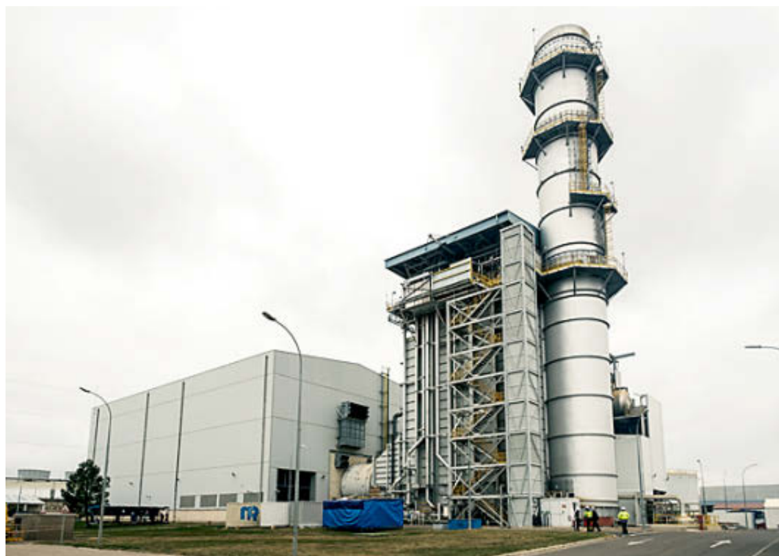
Central de ciclos combinados de Castejón (Navarra) de TotalEnergies. eE
