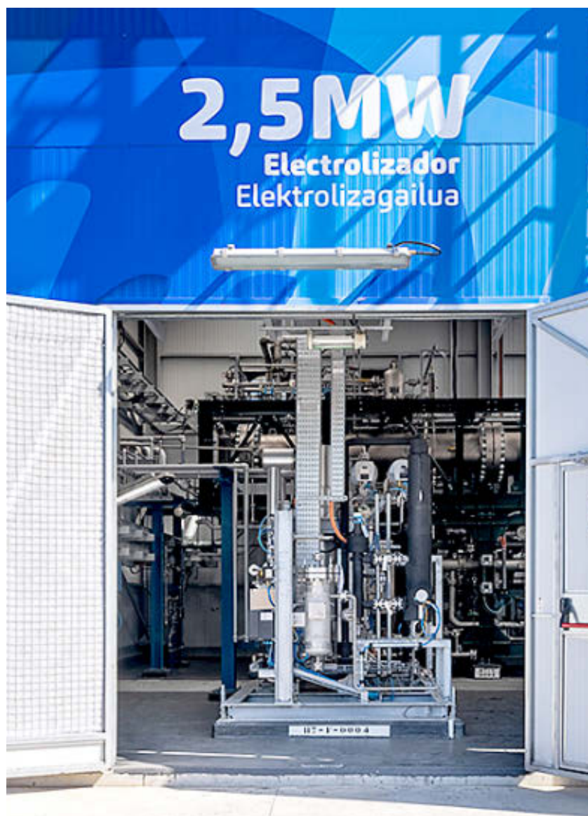
Electrolizador de 2,5 MW de Repsol en Bilbao, operativo desde 2023. I. Sierra
